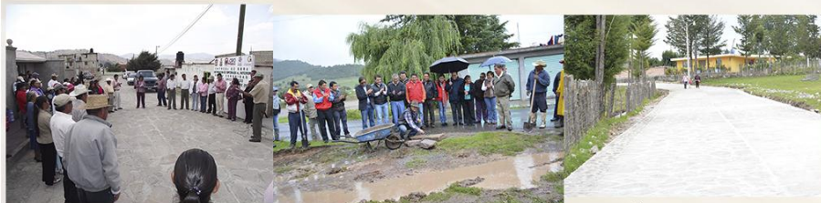
CONTINUACION DE EMPEDRADO EN LA LOCALIDAD DE ADOLFO LÓPEZ
